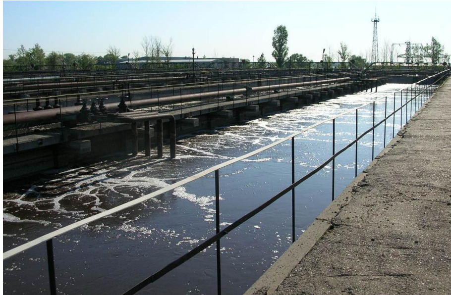
Рисунок 3 - Аэротенк для очистки промышленных и бытовых сточных вод на острове Голодный Волгоградской области
